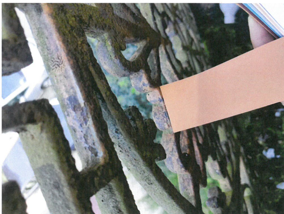
Fot.16. Budynek przy ul. Gen. L. Okulickiego 9 w Radomiu. Góra: fragment stolarki drzwiowej, lewy węgar drzwi wejściowych od strony zewnętrznej. Przyłożony wzór koloru o nazwie „oxidrot” nr 9003 S z kolornika Keim Avantgarde, dokładnie odwzorowuje widoczny w odkrywkach pierwotny kolor stolarki drzwi wejściowych do budynku. Poniżej: fragment bariery balkonu od strony elewacji frontowej. Przyłożony wzór koloru o nazwie „ oxidorange” nr 9011 0 z kolornika Keim Avantgarde 1 . Fot. N. Soran 21.08. 2023r.
