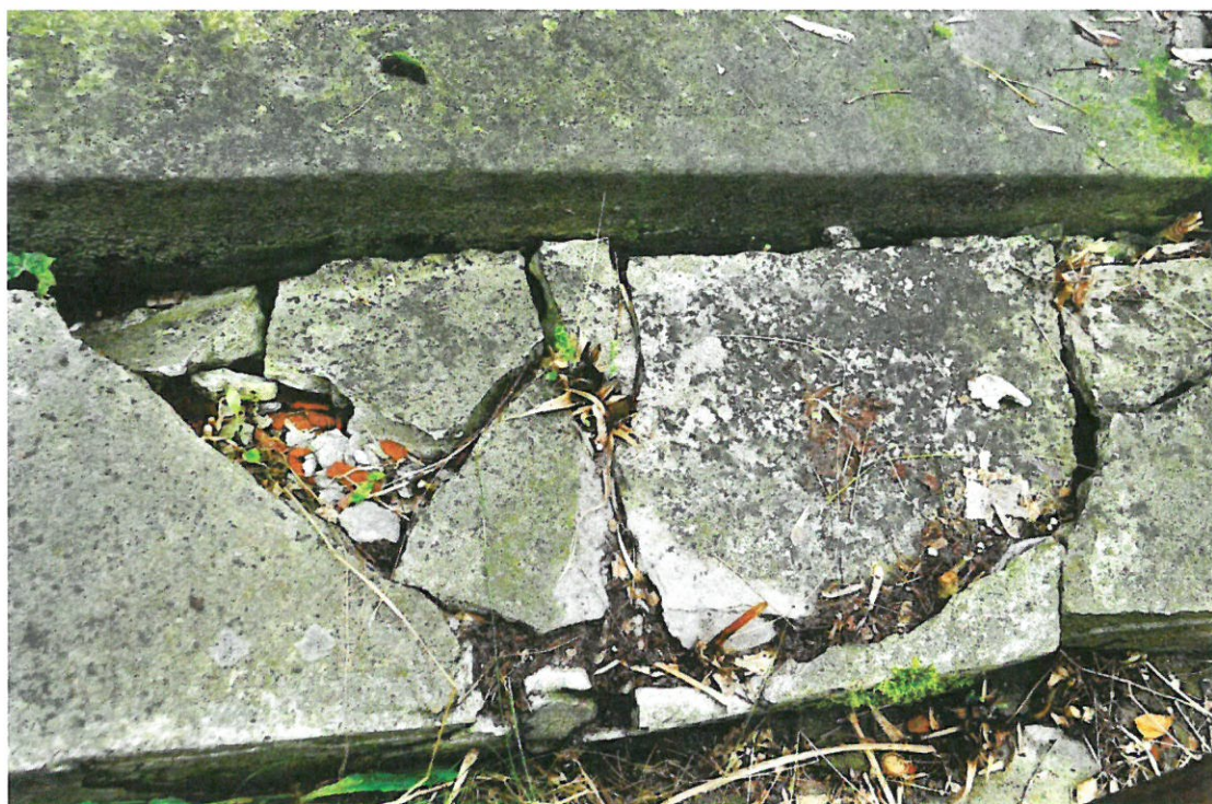
Fot.24, 25. Budynek przy ul. Gen. L. Okulickiego 9 w Radomiu. Góra: zniszczona kamieniarka stopni schodów. Dół: widok stopni schodów na elewacji frontowej – fragment. Fot. Natalia Soran 21.08. 2023r.
