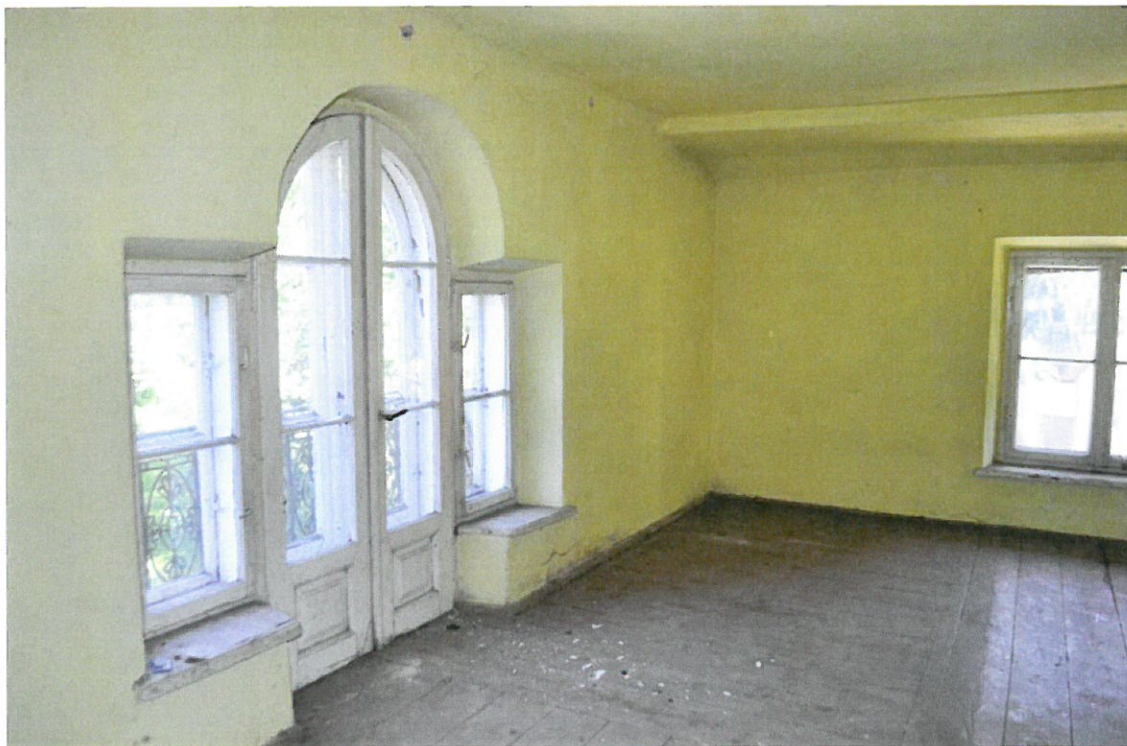
Fot.6,7. Budynek przy ul. Ge. L. Okulickiego 9 w Radomiu. Wyżej: pom. na poddaszu – w odkrywcę, gliniasta ciemna zaprawa i najstarszym kolorem bładoniebieskim. Poniżej : po. Z balkonem od elewacji frontowej na poddaszu – zachowany pierwotny charakter wnętrza. Fot. N. Soran 21.08. 2023r.
