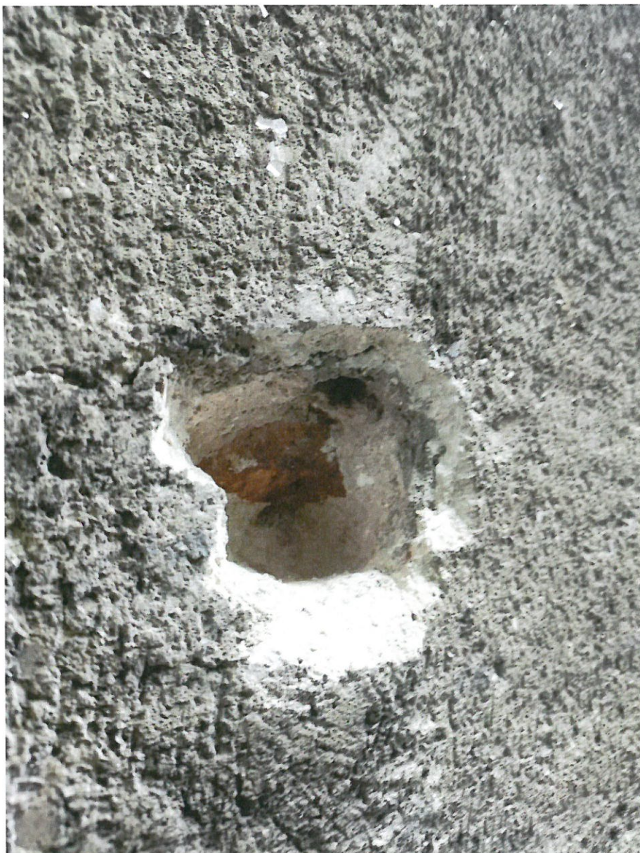
Fot.4. Budynek przy ul. Ge. L. Okulickiego 9 w Radomiu. Odkrywka wykonana na elewacji zachodniej. Widoczne: 1. Najstarsza zaprawa z wtrętami wapna – (podkładowa) i warstwa wierzchnia tynku szlachetnego. Widoczne jest opracowanie powierzchni narzędziem, ślady prowadzenia narzędzia drapiącego; na ciemny kolor wybarwiona jest tylko warstwa wierzchnia; wewnątrz zaprawa na naturalny ciepły kolor. Fot. Natalia Soran 21.08. 2023r.
