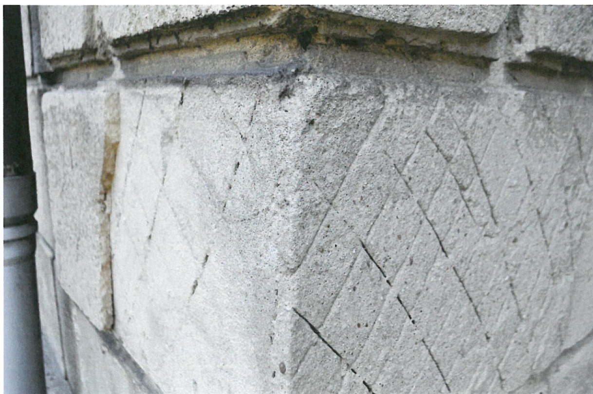
Fot.2, 3. Budynek przy ul. Ge. L. Okulickiego 9 w Radomiu. Widoczny detal – u góry: zbliżenie tynku szlachetnego na elewacji frontowej, z połyskującymi dodatkami; u dołu; warstwa podkładowa pod tynkiem szlachetnym z charakterystycznymi nacięciami. Fot. Natalia Soran 21.08. 2023r.
