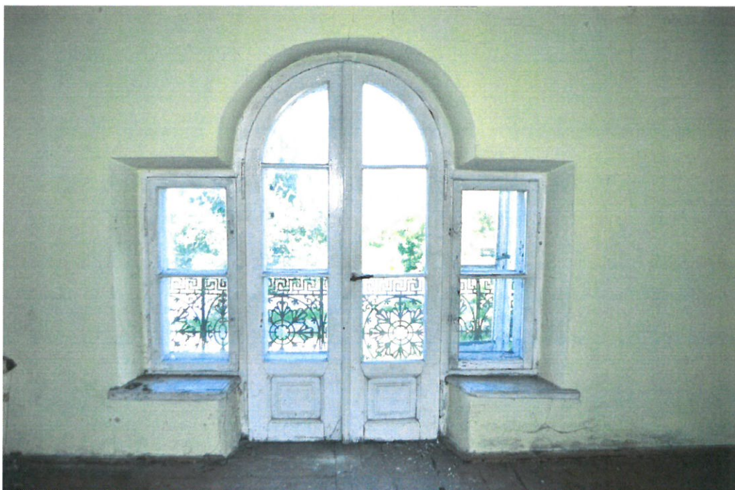
Fot.42,43. Budynek przy ul. Gen. L. Okulickiego 9 w Radomiu. Góra: Pomieszczenie z balkonem od strony frontowej , pierwotna stolarka okienna. Dół: okno balkonowe – fragment ; widoczne zbliżenie z oryginalna klamką z ozdobnym szyldem. Fot. Natalia Soran 21.08. 2023r.
