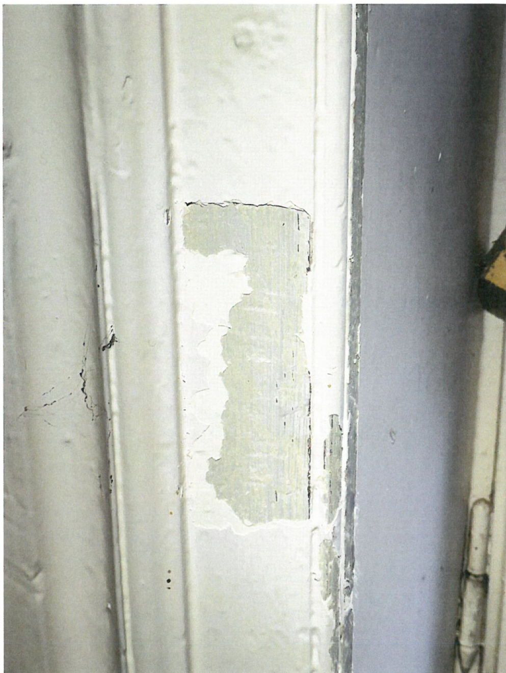
Fot.11. Budynek przy ul. Gen. L. Okulickiego 9 w Radomiu. Odkrywka 9, w pomieszczeniu 1/10, lewa okiennica – środkowy fragment; widoczna pierwotna kolorystyka w odcieniu jasnej szarości i delikatnej zieleni , widoczne są bardzo cienkie pociągnięcia pędzla, które mogą sugerować wykonany mazerunek. Jest to dominująca kolorystyka stolarki wewnętrznej zarówno na parterze jak i na poddaszu, stanowiąca pierwotny wystrój wnętrza. Fot. Natalia Soran 21.08.2023r.
