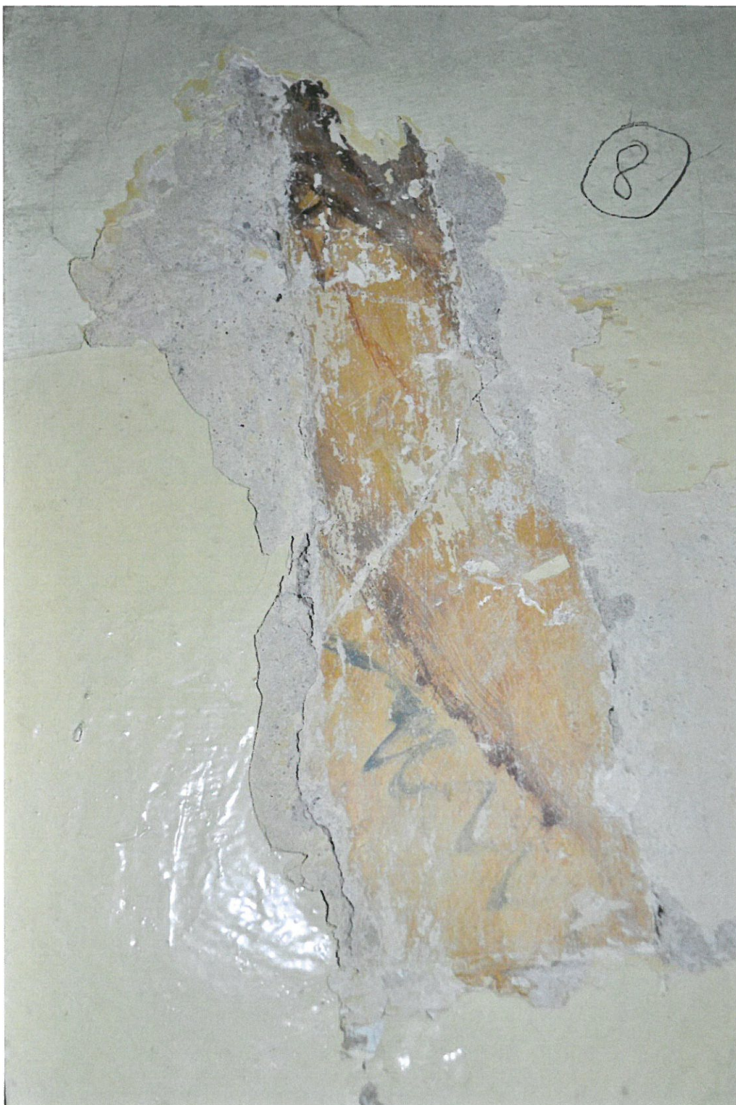
Fot.10. Budynek przy ul. Gen. L. Okulickiego 9 w Radomiu. Odkrywka 8 : widoczny zachowany pierwotny tynk z warstwą sztablatury na bazie gipsu (?) oraz warstwa malarską naśladującą marmur tzw. marmuryzacją, korytarz sieni 1 / 2. Fot. Natalia Soran 21.08.2023r.
