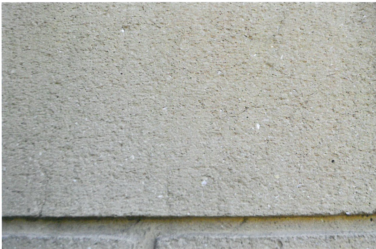
Fot.2, 3. Budynek przy ul. Ge. L. Okulickiego 9 w Radomiu. Widoczny detal – u góry: zbliżenie tynku szlachetnego na elewacji frontowej, z połyskującymi dodatkami; u dołu; warstwa podkładowa pod tynkiem szlachetnym z charakterystycznymi nacięciami. Fot. Natalia Soran 21.08. 2023r.
