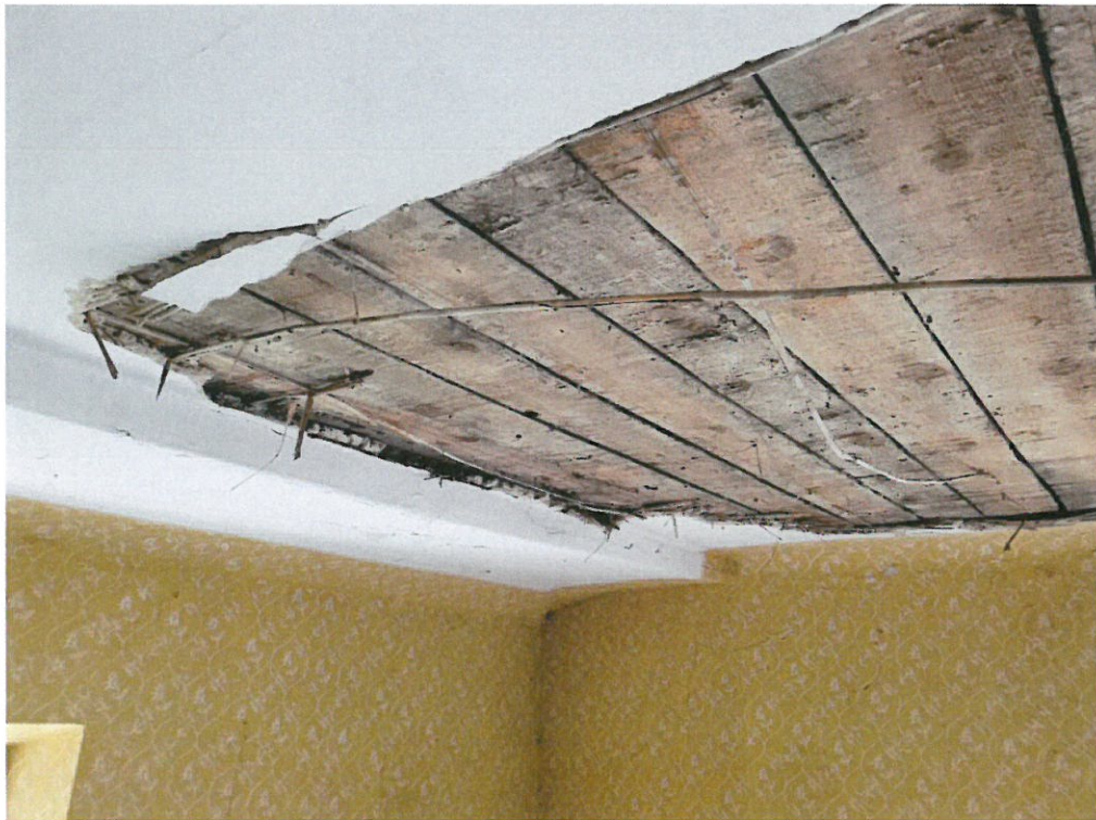
Fot.6,7. Budynek przy ul. Ge. L. Okulickiego 9 w Radomiu. Wyżej: pomieszczenie poddasza-odkrywka na suficie tzw. podsiębitka ( deskowanie i trzcina).Poniżej : parter – odkrywka w pom. 1/ 10, zachowany jest tynk pierwotny, ale nie występują ślady koloru. Fot. Natalia Soran 21.08. 2023r.
