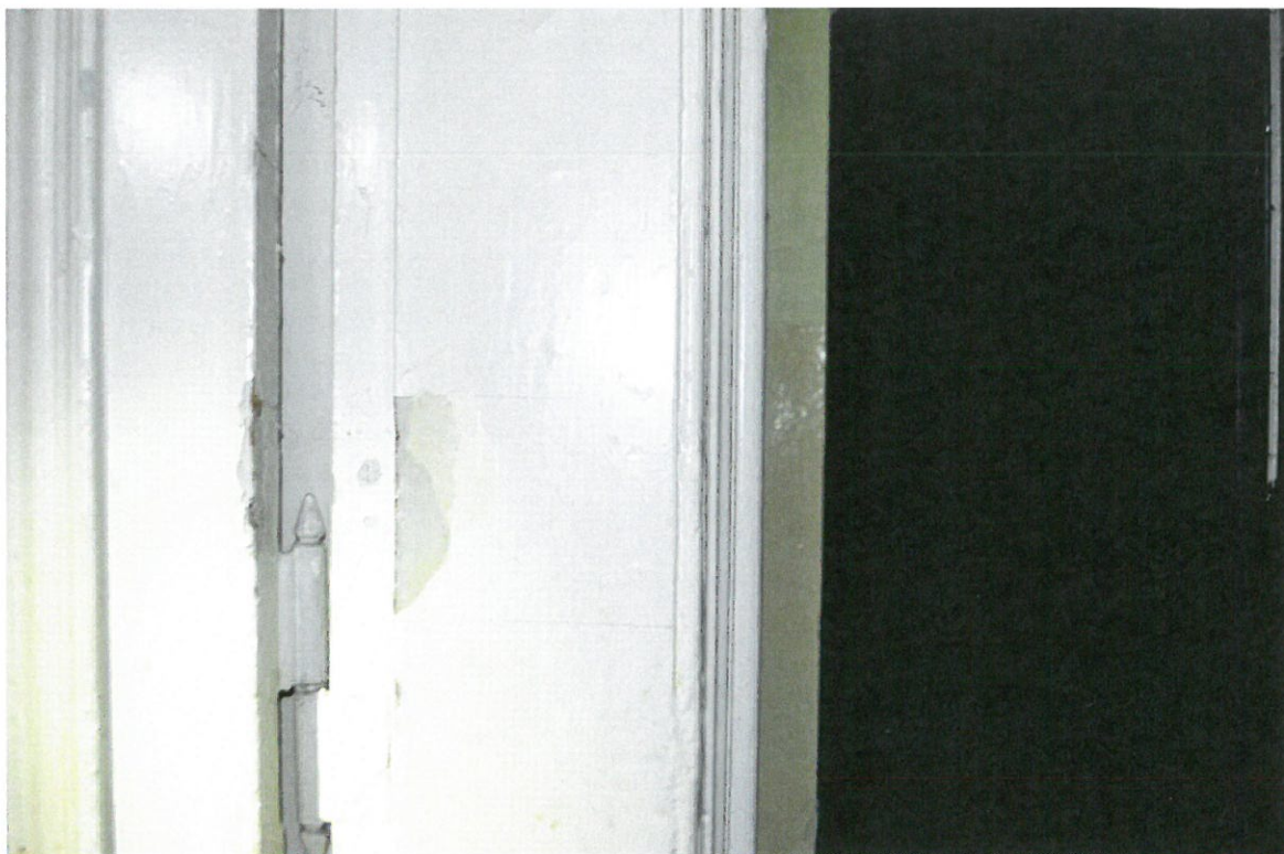
Fot.14,15. Budynek przy ul. Gen. L. Okulickiego 9 w Radomiu. Góra: fragment stolarki drzwiowej pomiędzy pom. 1/24 a 1/25 na parterze, lokalizacja. Poniżej: odkrywka – zbliżenie, kolor szarozielony, szrafowany to pierwotna kolorystyka stolarki w pom. parteru, zbliżona do koloru nr 92 z kolornika Keim Avantgarde . N. Soran 21.08. 2023r.
