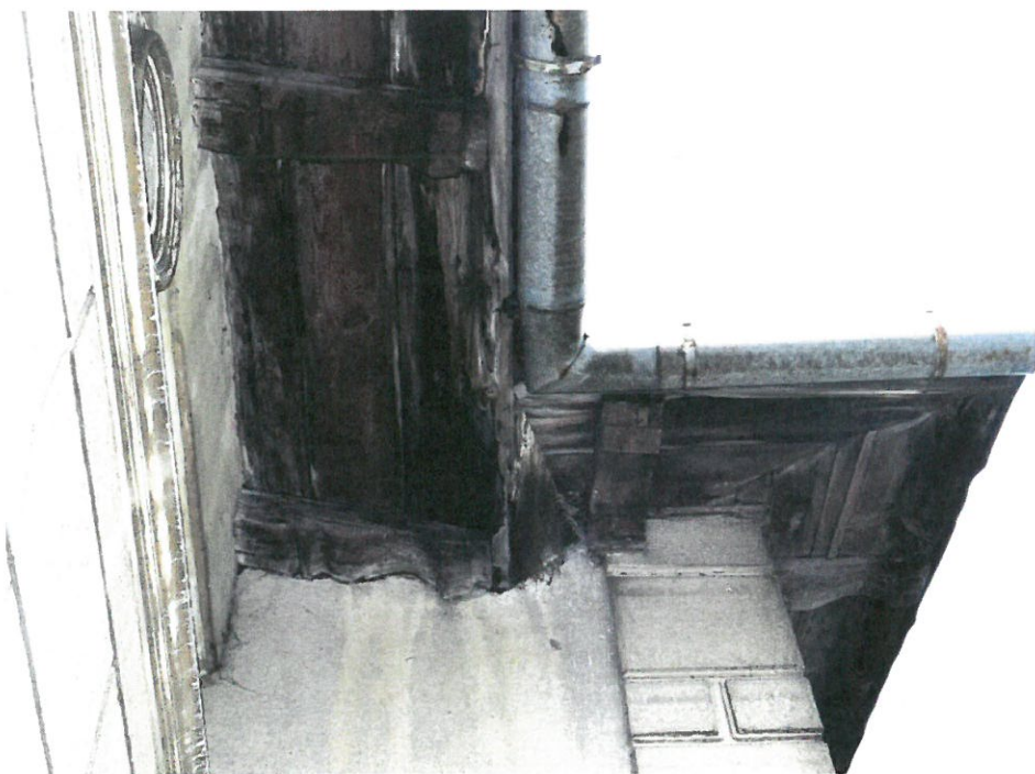
Fot.28,29. Budynek przy ul. Gen. L. Okulickiego 9 w Radomiu. Góra: podbicie z desek strefy pomiędzy dachem a ścianą. Dół: podbicie – widok od strony frontowej. Stan przed remontem konserwatorskim. Fot. Natalia Soran 21.08. 2023r.
