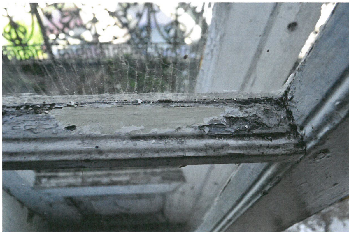
Fot.12,13. Budynek przy ul. Gen. L. Okulickiego 9 w Radomiu. Góra: stolarka okienna z drewna sosnowego, naturalna odkrywka na węgarze okna parteru, od strony frontu. Dół: odkrywka na stolarce okna poddasza, balkonowego- najstarsza kolorystyka w odcieniu zielonkawej bieli. 21.08. 2023r.
