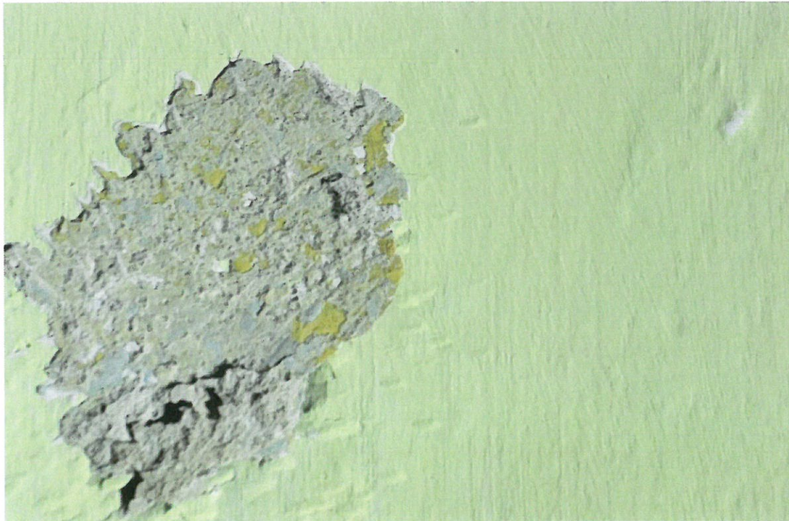
Fot.6,7. Budynek przy ul. Ge. L. Okulickiego 9 w Radomiu. Wyżej: pom. na poddaszu – w odkrywcę, gliniasta ciemna zaprawa i najstarszym kolorem bładoniebieskim. Poniżej : po. Z balkonem od elewacji frontowej na poddaszu – zachowany pierwotny charakter wnętrza. Fot. N. Soran 21.08. 2023r.
