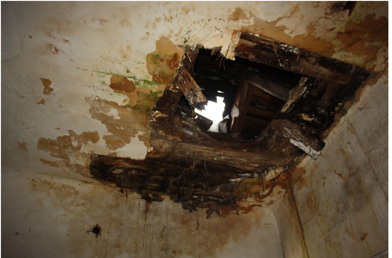
Fot. 20. Uszkodzony strop nad kłaką schodową.
