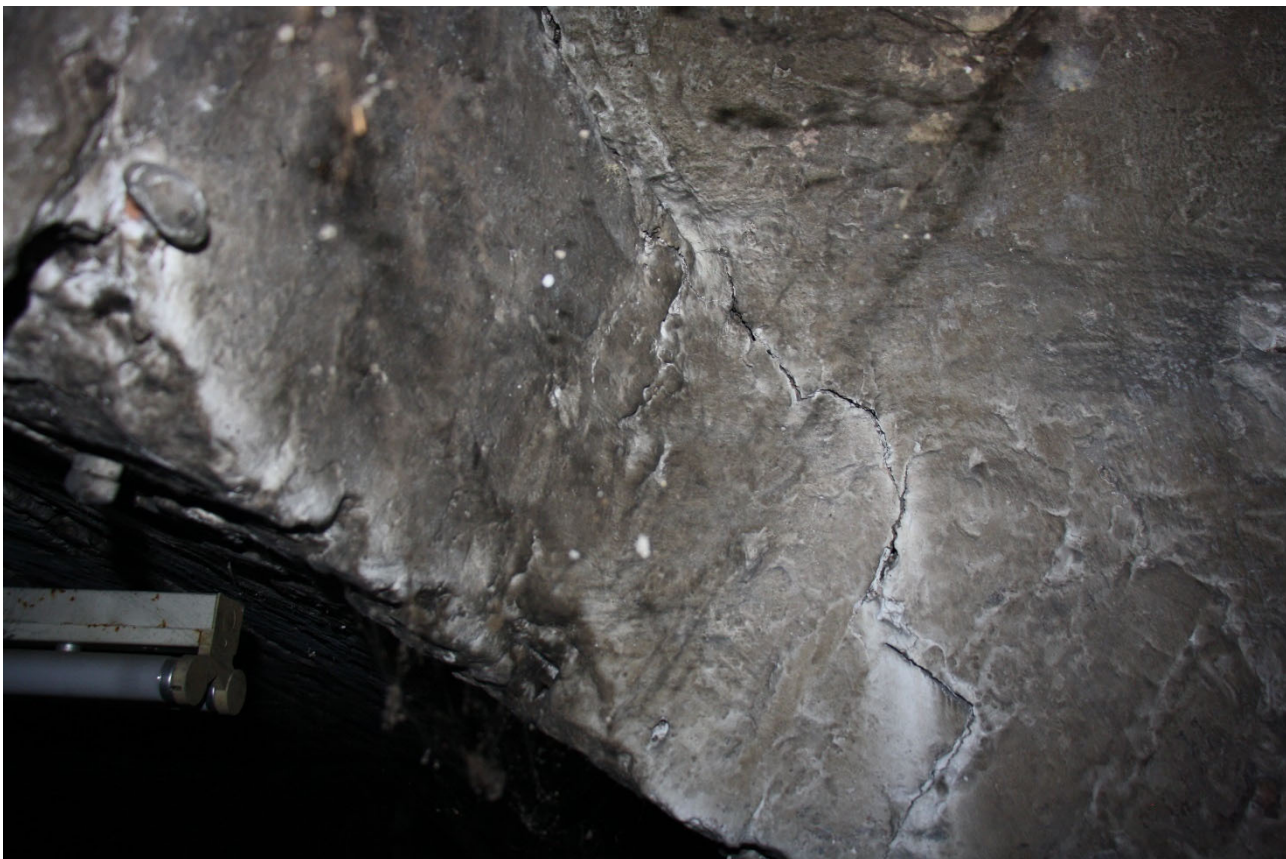
Fot. 6. Zarysowanie sklepienia – pod częścią mieszkalną zakładu rzemieślniczego.
