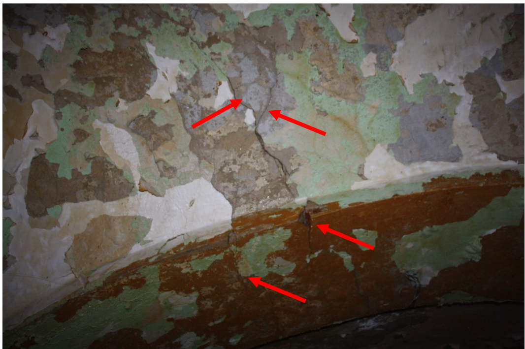
Fot. 18. Pęknięcia stropu nad parterem.
