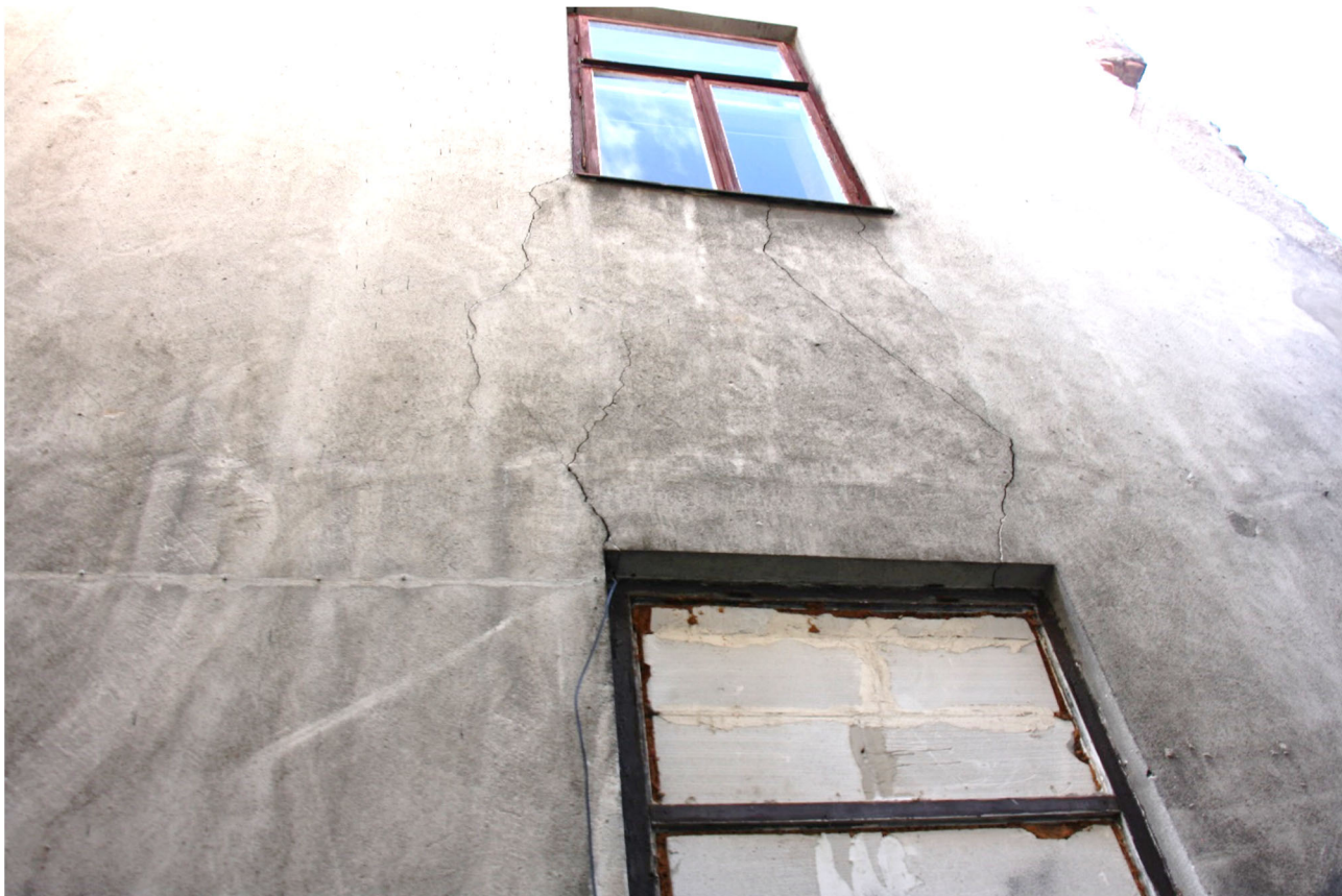
Fot. 15. Przebieg pęknięcia z Fot. 13 i 14.
