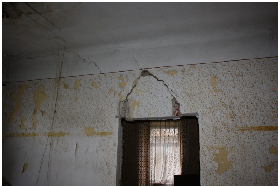
Fot. 12. Uszkodzone nadproża nad drzwiami – I piętro.
