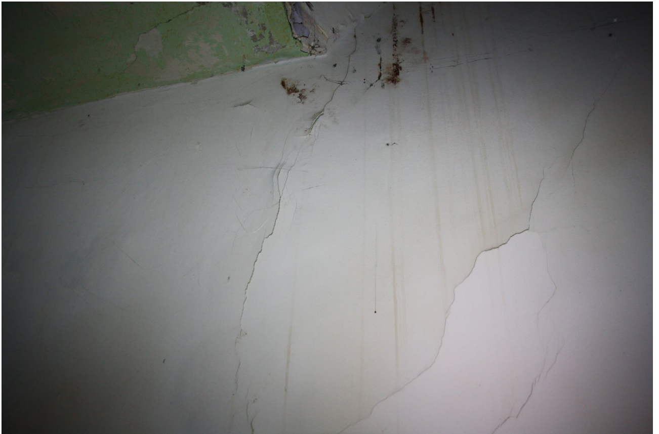
Fot. 11. Spękania w pozostałej części mieszkalnej parteru.
