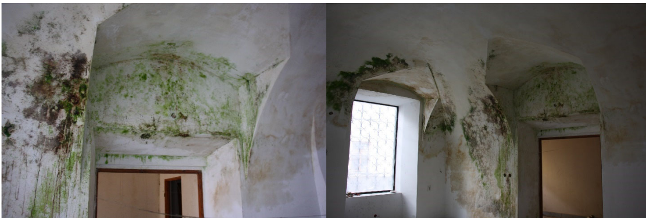
Fot. 10. Zaatakowane przez mikroorganizmy połacie ścian parteru – część druga budynku.
