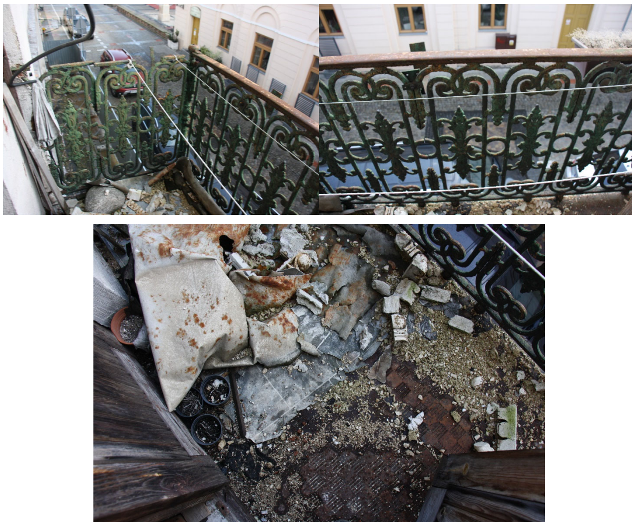
Fot. 27. Balkon – widok z kondygnacji I piętra. Widoczna uszkodzona balustrada.
