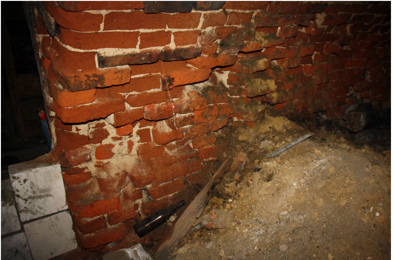
Fot. 3. Uszkodzona cegła – pomieszczenie pod zakładem rzemieślniczym.
