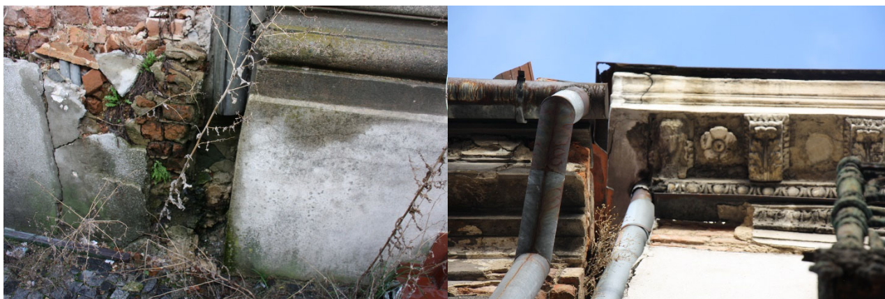
Fot. 25. Stan techniczny obróbek blacharskich
