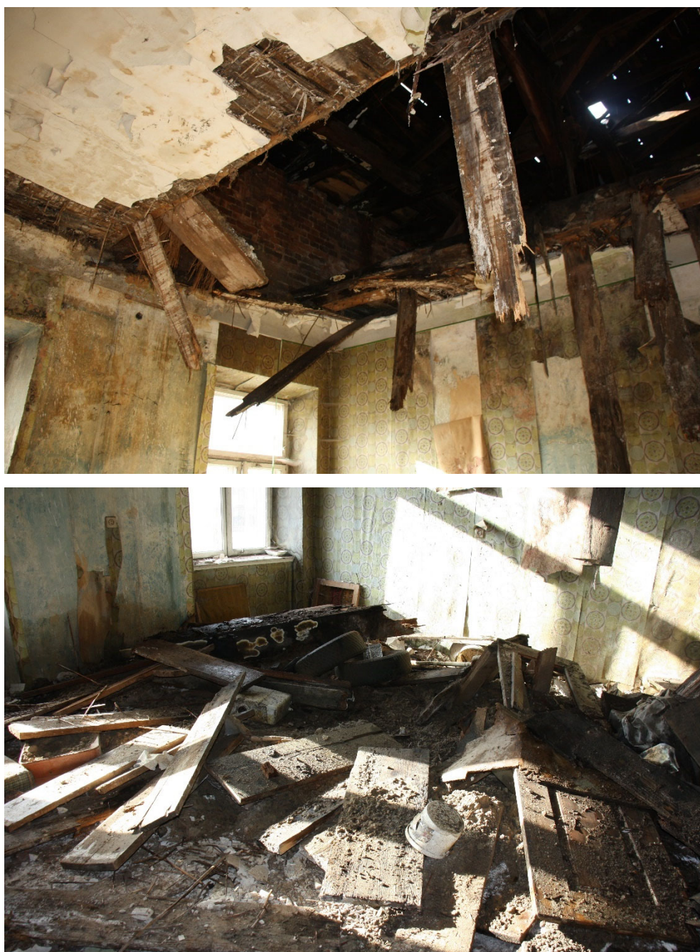
Fot. 19. Zawalony strop nad I piętrem – gruzowisko w pokoju nad lokalem rzemieślniczym.
