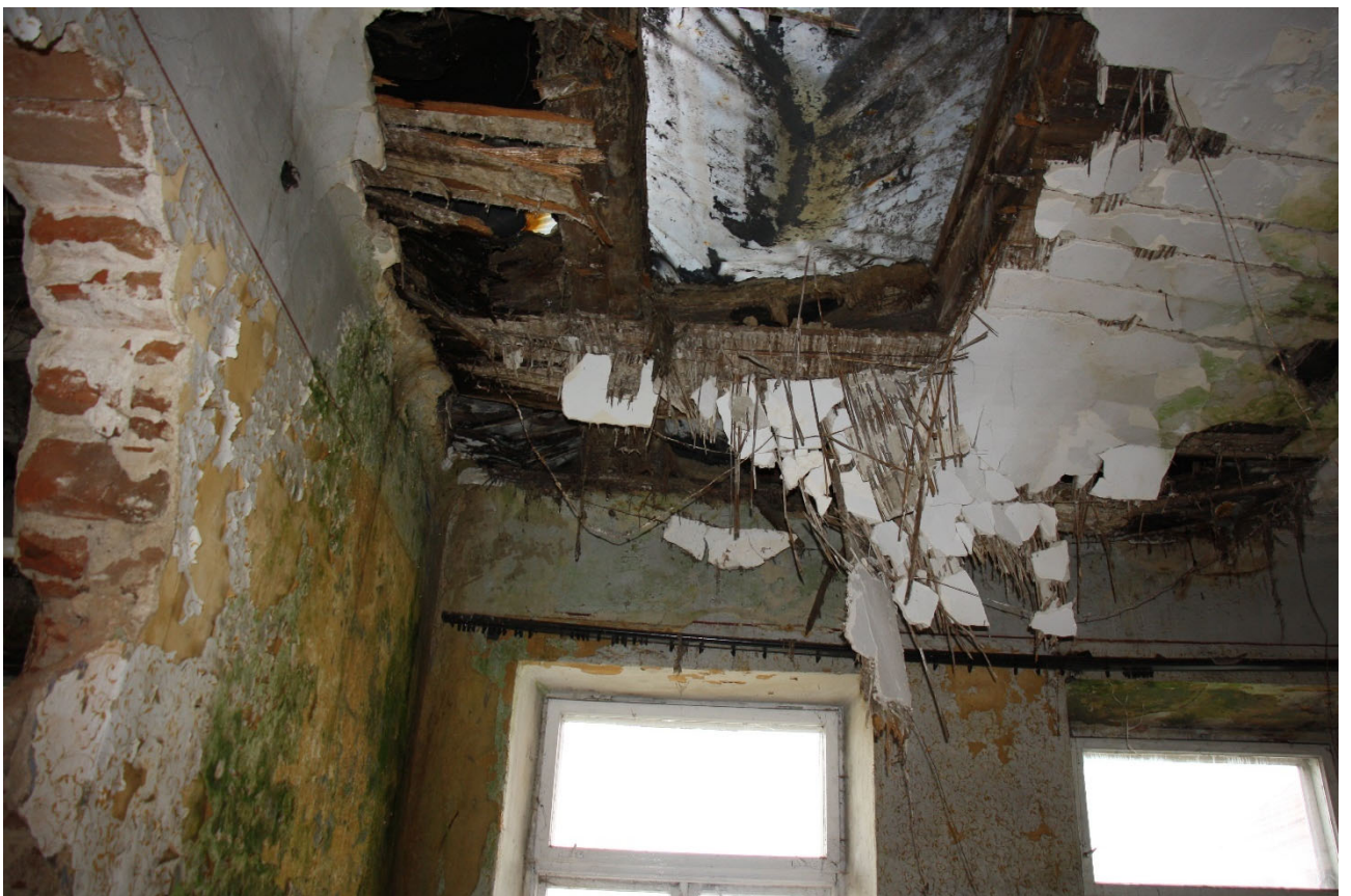
Fot. 21. Uszkodzony strop nad I piętrem – lokal mieszkalny od strony ul. Rwańskiej
