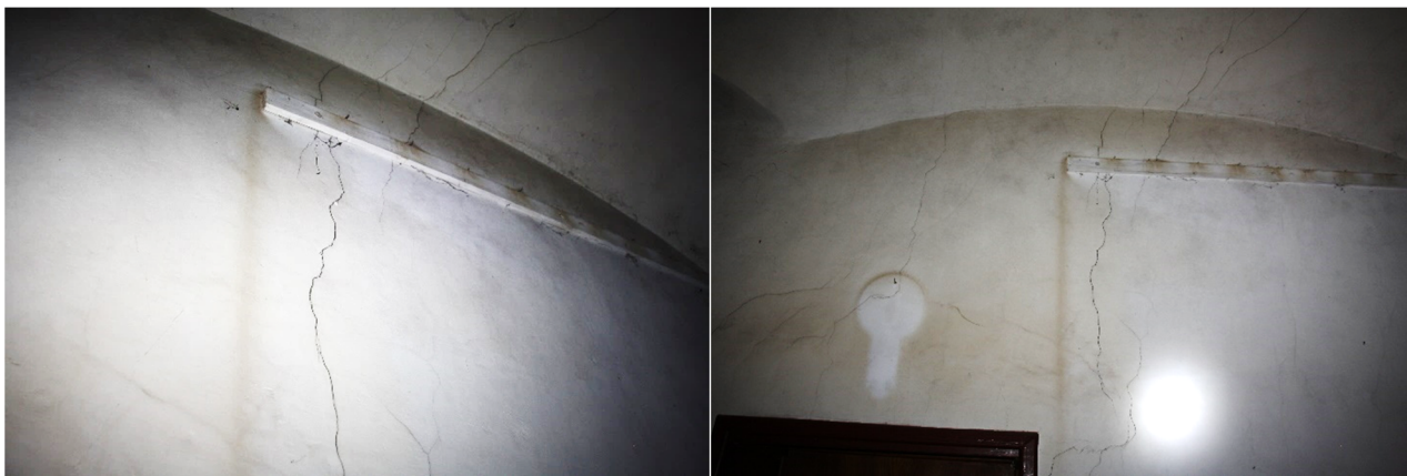
Fot. 9. Spękania ścian konstrukcyjnych w części mieszkalnej zakładu.
