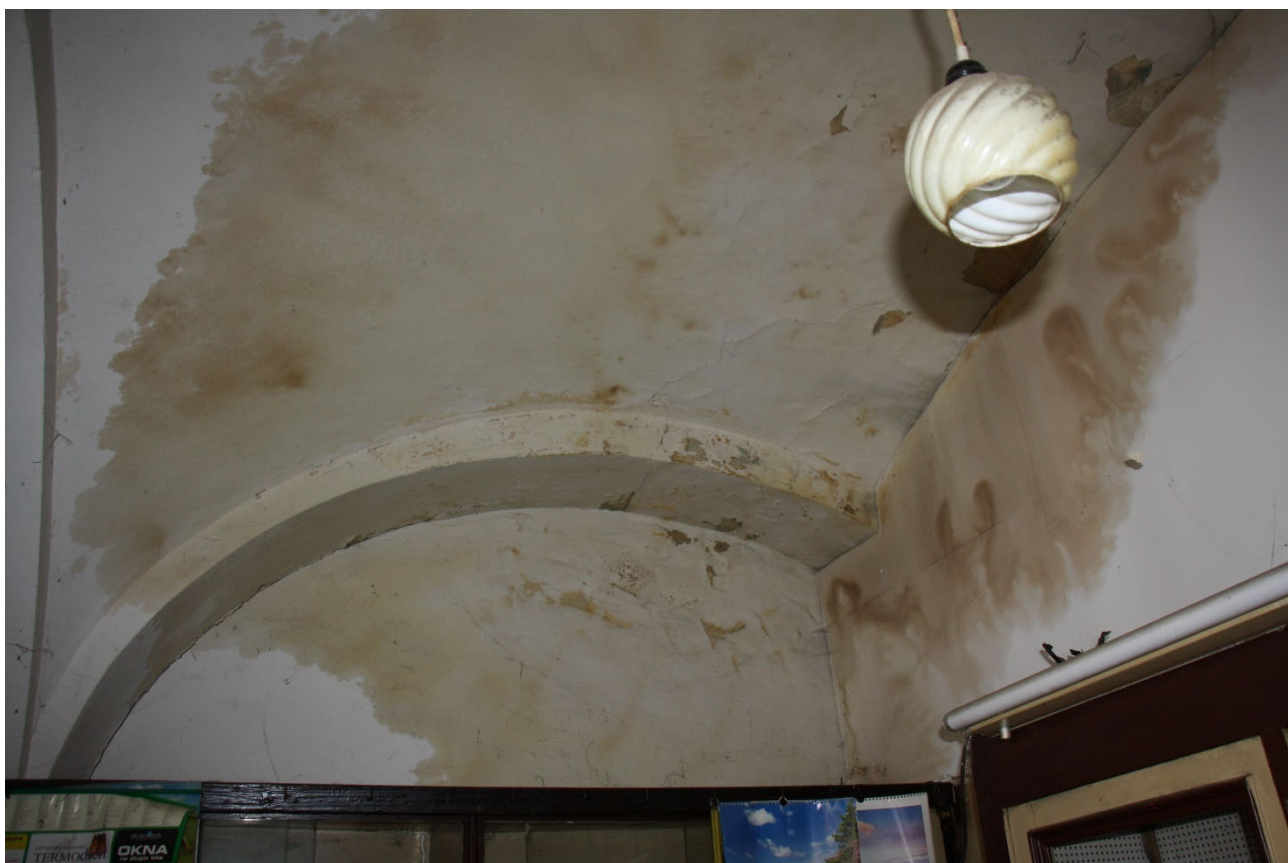
Fot. 8. Zacieki w innej części zakładu.
