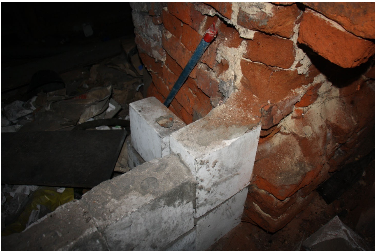
Fot. 5. Uszkodzenie podstawy sklepienia.
