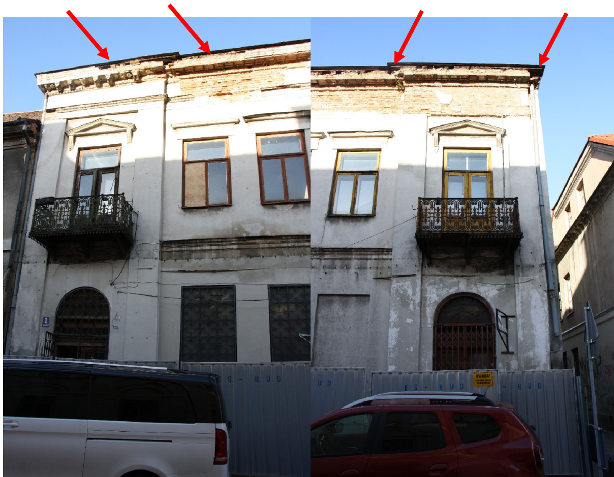
Fot. 17. Widoczne liczne odspojenia tynków na ścianie kolankowej (osłonowej) oraz przy gzymsie ceglany przy koronie muru.
