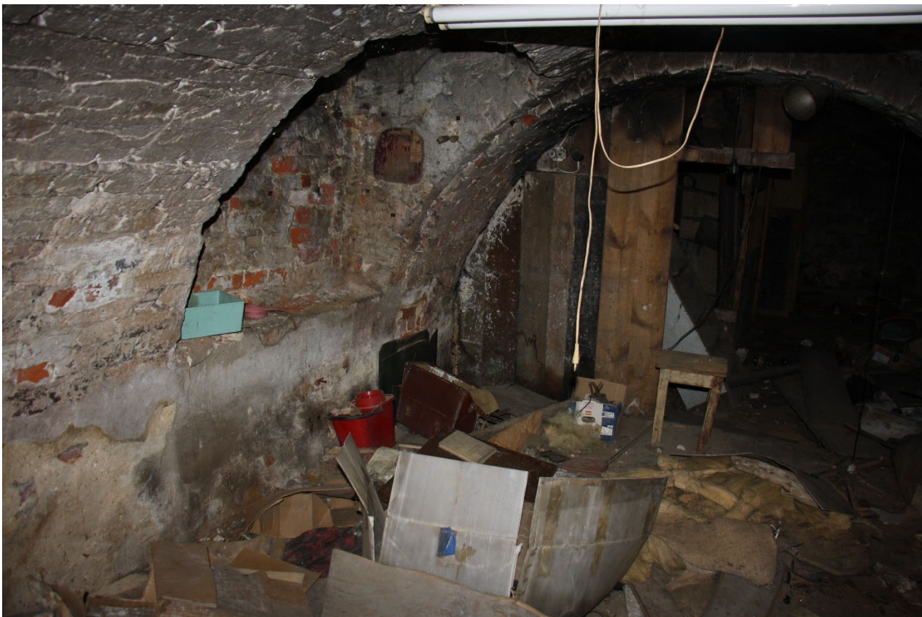
Fot. 4. Sklepienie nad piwnicą – pod częścią mieszkalną zakładu rzemieślniczego.
