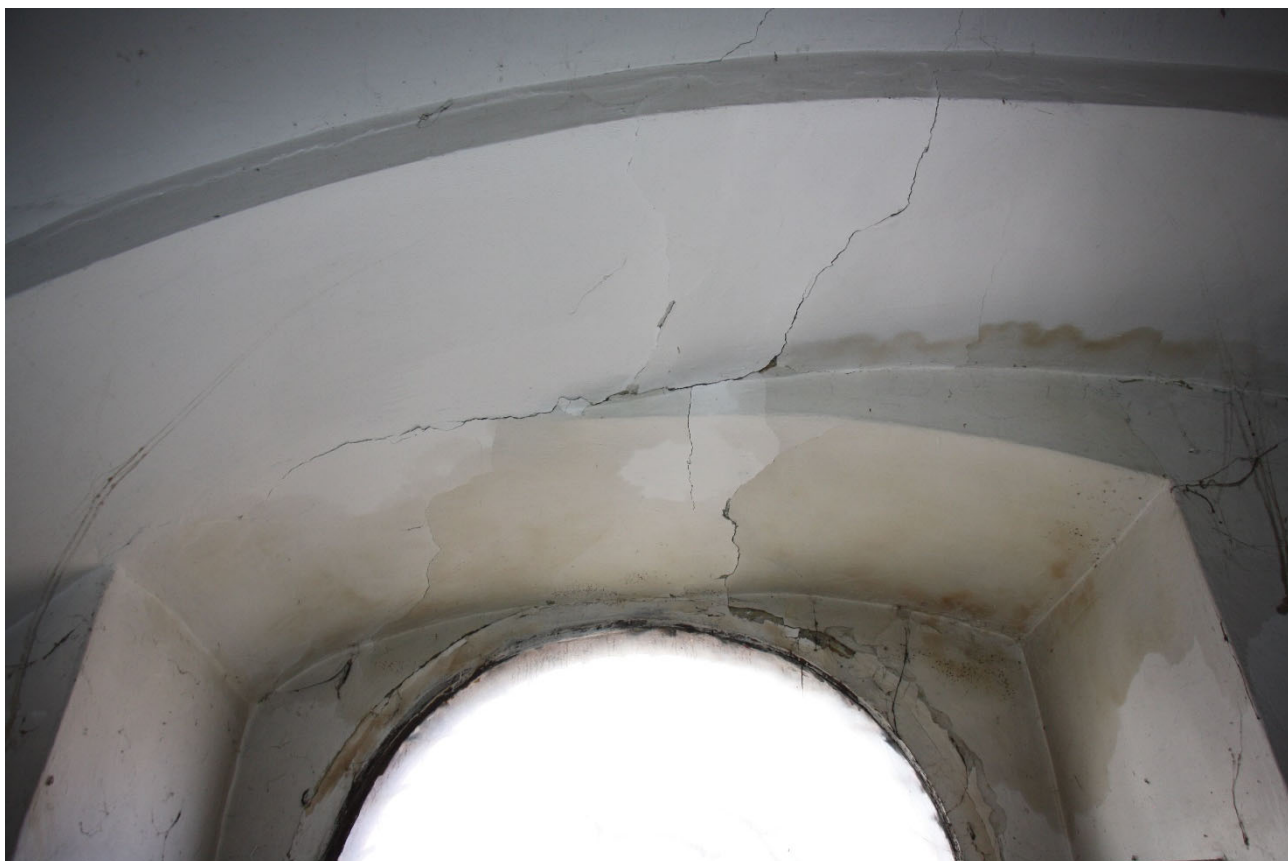
Fot. 7. Spękanie nadproże nad drzwiami wejściowymi do lokalu rzemieślniczego wraz z zaciekami od wody opadowej.
